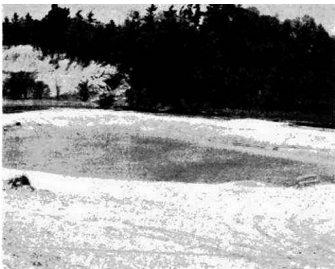
Fig. 4a. Sediment basin.
